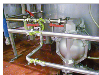
Pompa sanitarna 3" stosowana do transportu baz dla szamponów
