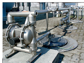
Pompa membranowa 1 1/2" w systemie transferu chlorku metylenu
