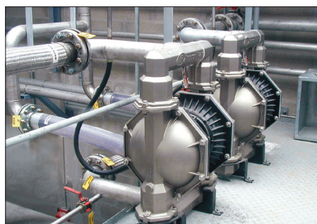
Pompy membranowe 1 1/2" zasilające reaktor w procesie chemicznym
