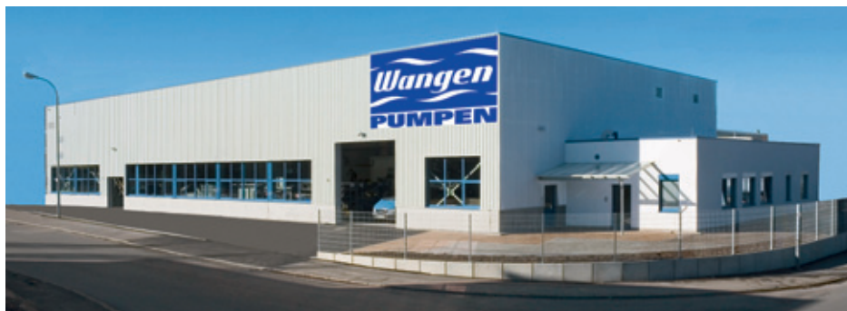
Zakład statorów w siedzibie firmy w Wangen w Allgäu
