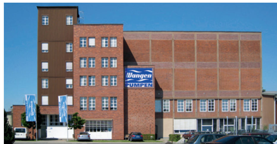
Siedziba fabryki pomp Wangen w Allgäu
